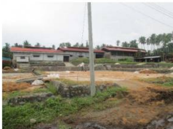
バイオログフィルター工場 全景
