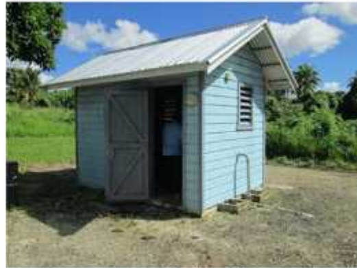
写真.ポンプ室
