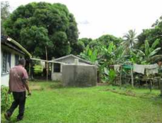
写真.天水タンク（コンクリート製）
