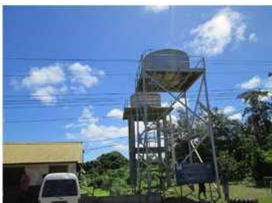
写真.日本の援助による高架タンク
